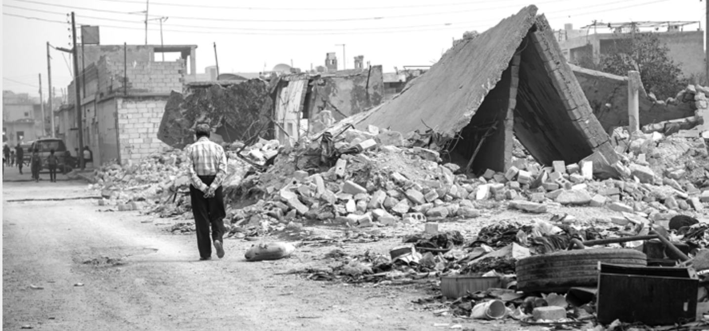
Dégâts, destruction et déplacements importants à Alep. Crédit photo : UNHCR/Antwan Chnkdji, octobre 2018
